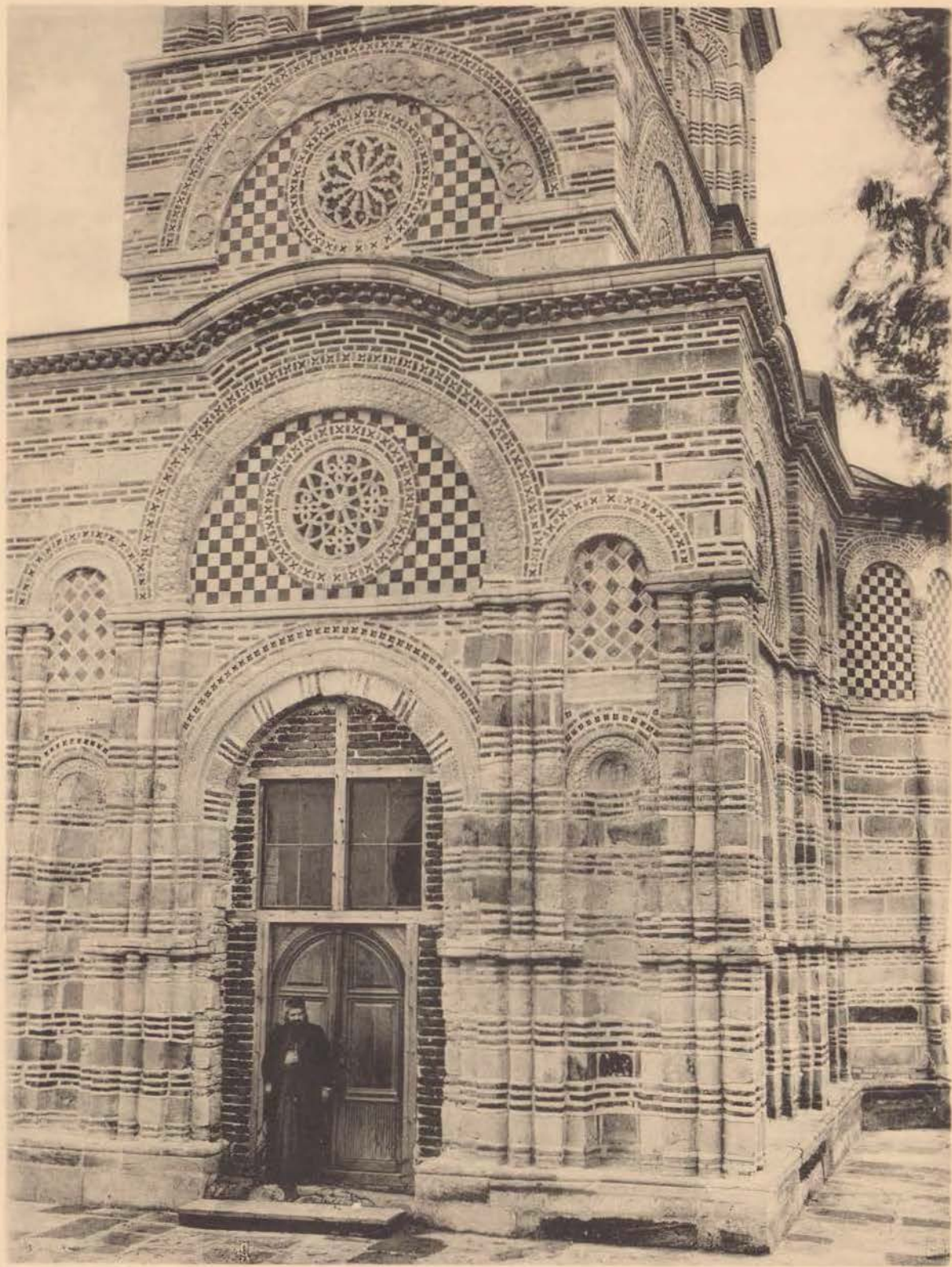
192. Kruševac. Façade occidentale.
